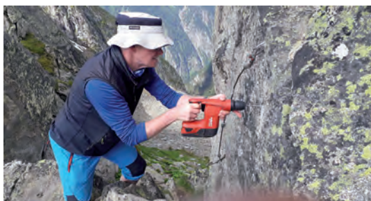
Anbringen einer Wegetafel
