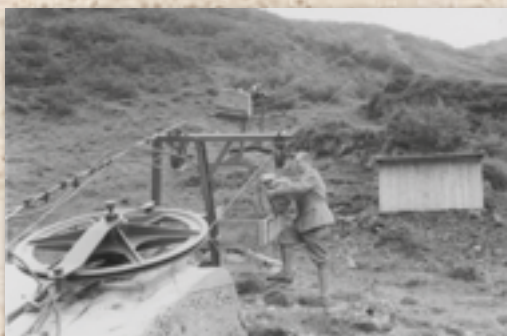
1959: Im Tal an der Seilbahn – Gepäckverladung
