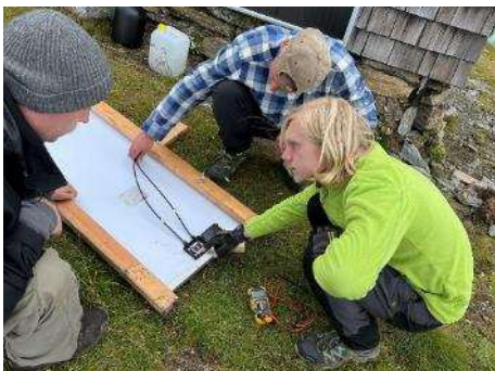
Solarzellenreparatur auf der Böseckhütte (H. Klink)
